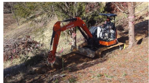
強度測定のための作業道作設
