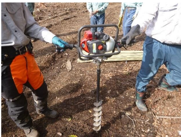
植え穴掘りに使用したアースオーガー
