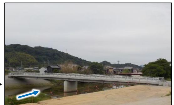
砂川（岡山市東区竹原）の復旧状況
