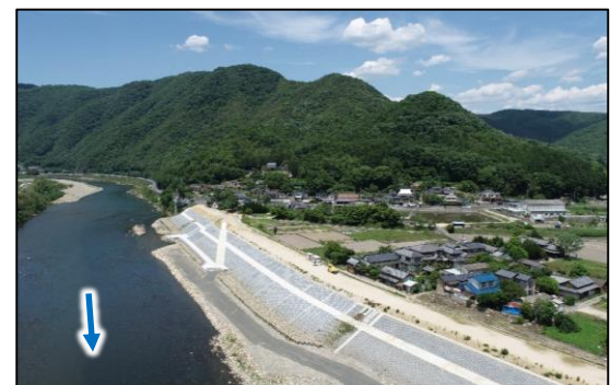
高梁川（総社市日羽）の復旧状況
