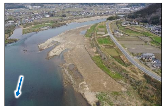
旭川（岡山市北区御津川高）の河道掘削状況
