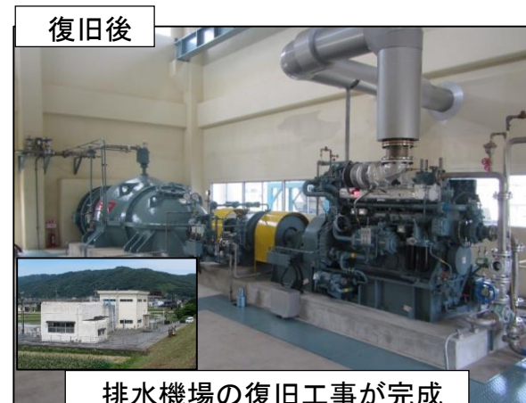
排水機場の復旧状況（倉敷市真備町）
