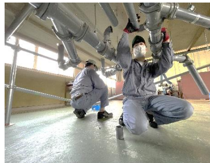
【トイレ・洗面器施工実習】
