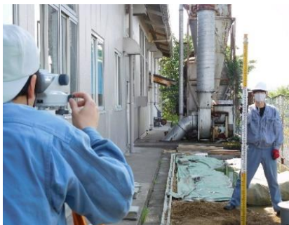
【配管施工実習】
