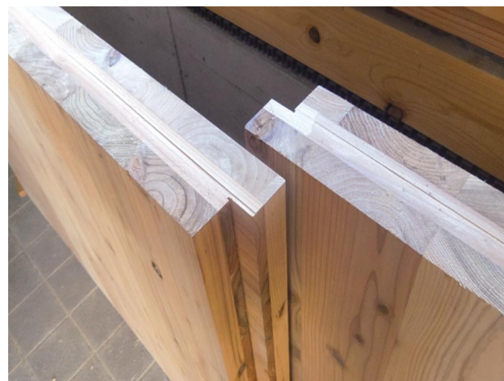
[参考:腰壁(施工中)]
