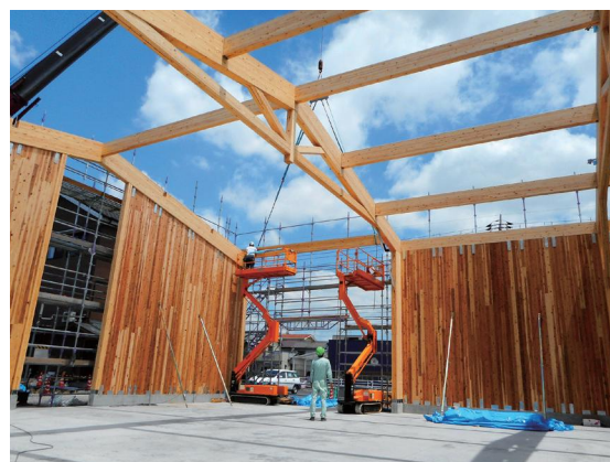
[参考:施工状況]
