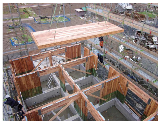
[参考:施工状況]
