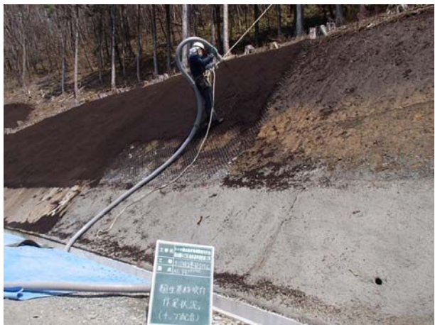
チップ配合植生基材吹付工
