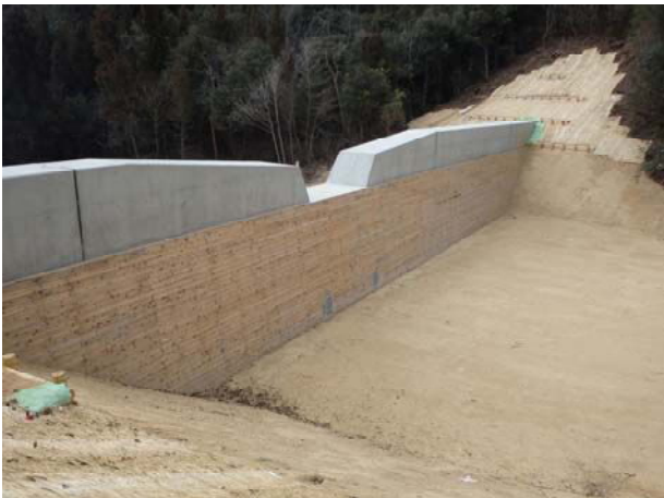
木製残存型枠工
