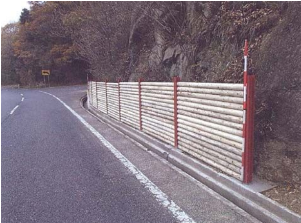
道路簡易防護柵
