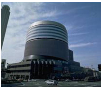
■岡山シンフォニービル(岡山市)■
