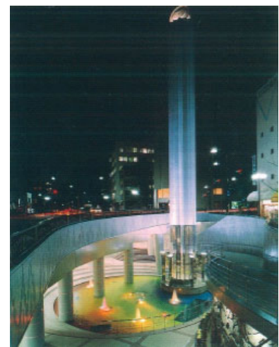
■ 城下地下交通広場（岡山市） ■ （城下地下広場）
