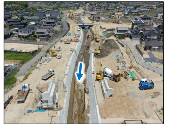
末政川（倉敷市真備町有井）の復旧状況
