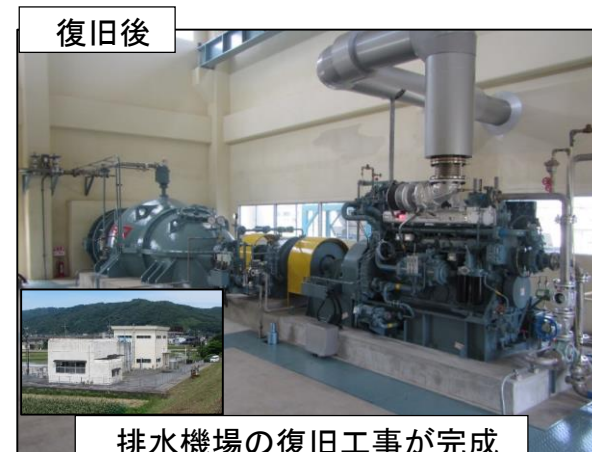
排水機場の復旧状況 (倉敷市真備町)
