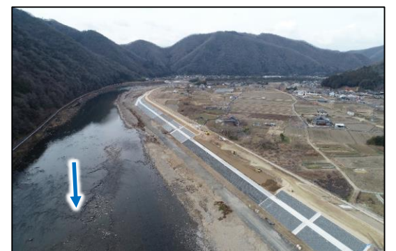
高梁川（総社市日羽）の復旧状況
