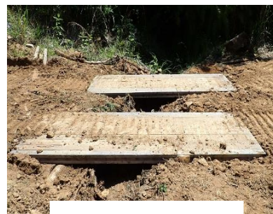
図 ヒノキCLTの設置状況
