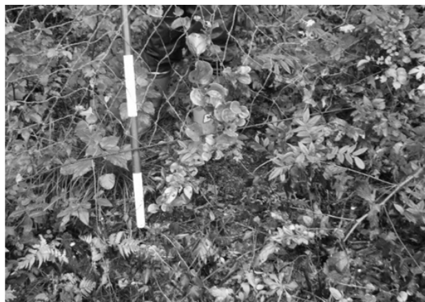
図-17 アンカー抜け・打ち込み不足
