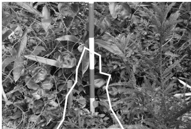
図-14 ネットの継ぎ方不良
