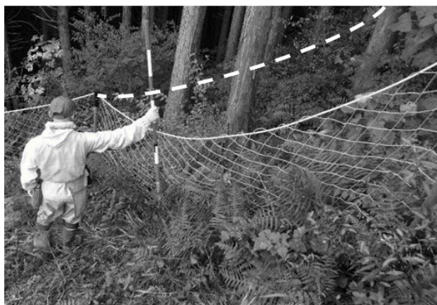
図-15 ネットの下垂・高さ不足
