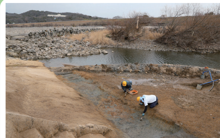
⑤溝 (南西から撮影)
