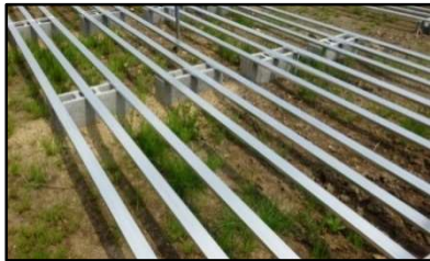
図-8-1 軽天材を使用したトレイ台 (豊並樹苗生産組合)
