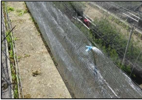
図-12-2 トレイ側面の保護 (反射シートの設置)
