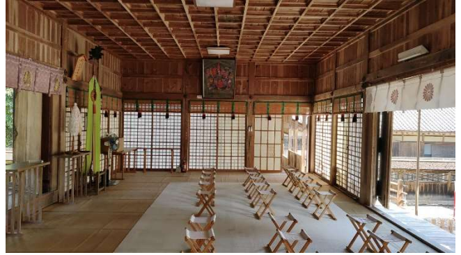
中山神社拝殿内部状況
