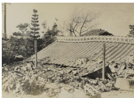
昭和南海地震 岡山市三幡地区付近 (山陽新聞社提供)
