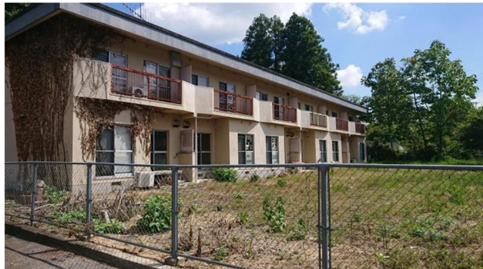
建物(2) 共同住宅
