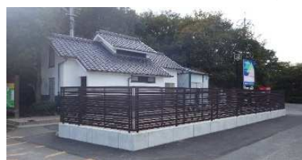
➤長寿命化対象施設（王子ヶ岳公衆便所）
