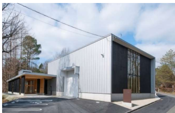
林業技術研修棟（外観）
