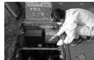
(農業集落排水施設の点検)
