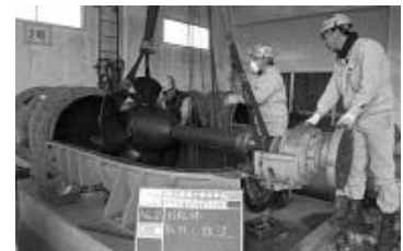
(排水機の整備・補修)
