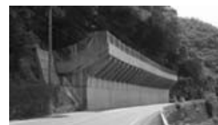
(落石防護柵の設置)
