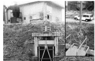
(樋門の巻き上げ装置の整備)
