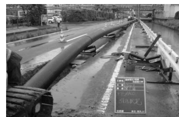
(工業用水配水管の更新・高密度ポリエチレン管の布設例)
