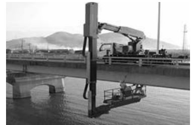
(農道橋の点検)
