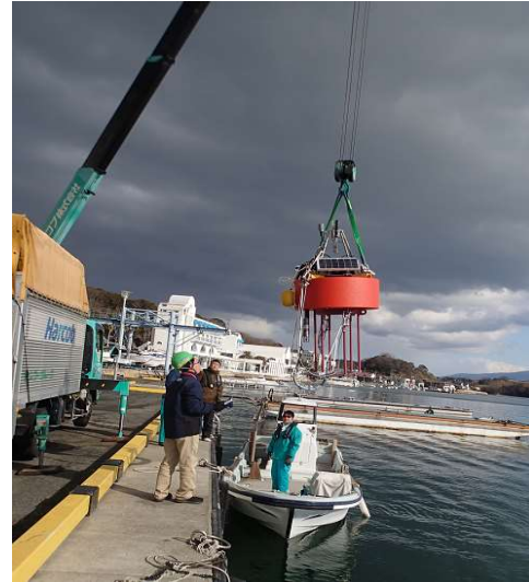
図1 テレメーターブイ設置の様子
