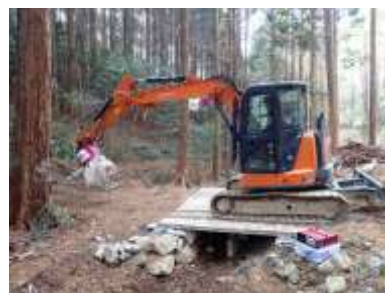
図2 ザウルの走行状況
