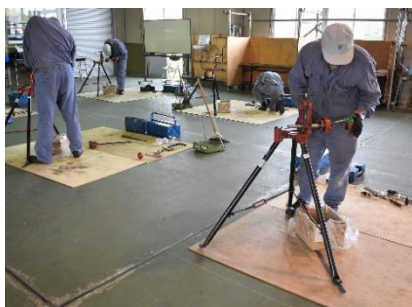
【配管施工実習】
