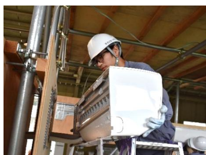
【エアコン取付け実習】
