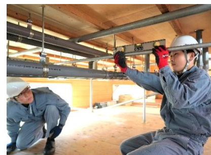
【トイレ・洗面器施工実習】
