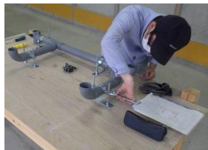
床排水配管実習
