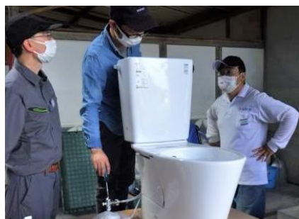
衛生器具設置
