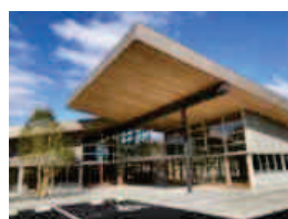
【CLTによる木造建築】
