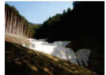
治山ダムの整備
