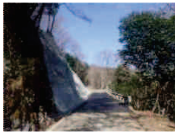
改良（井原市芳井町川相地内）
