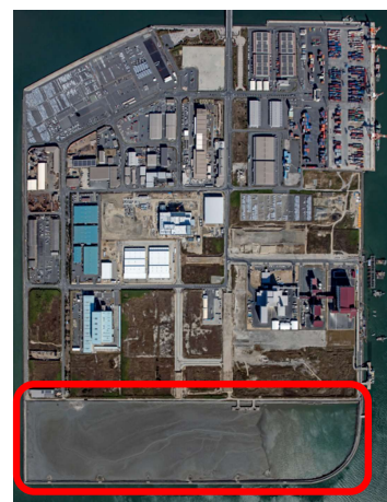
水島港玉島地区 (玉島ハーバーアイランド) 浚渫土砂処分場(沖出し部)
