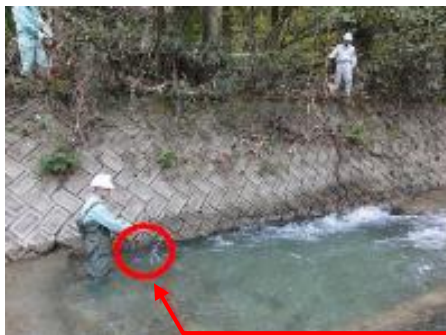
ポールを差し込み、洗堀を確認する
