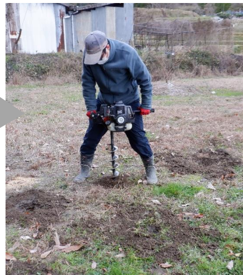
図2 エンジンオーガーによる排水対策の様子
