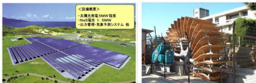
図 43 メガソーラー(左)と小水力発電(右)の外観
