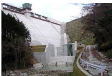
三室小水力発電所(企業局)
