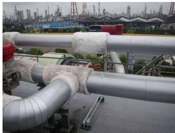
0.2MPaG 蒸気配管付設状況
