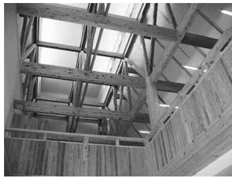
小径木重ね梁・柱構造
