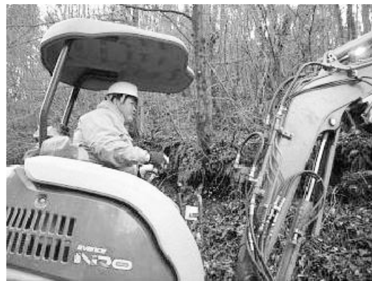
作業道の補修作業中
