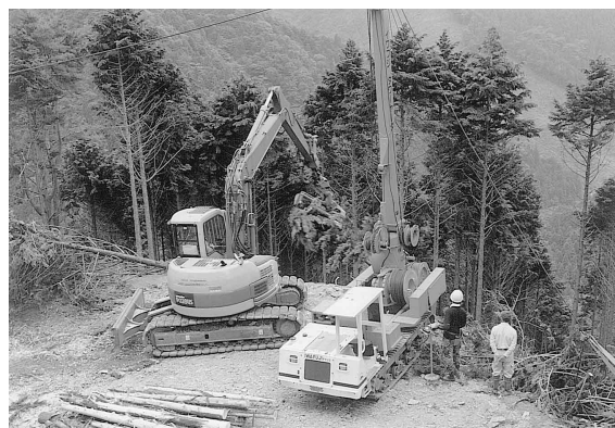
小型タワーヤードシステムによる列状間伐
