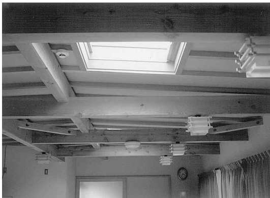
梁・桁の状況
