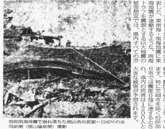
昭和南海地震で崩れ落ちた岡山市の民家=1946年の合同新聞(現山陽新聞)撮影
