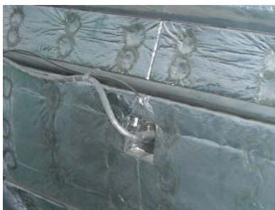
スポット溶接による断熱材の固定
