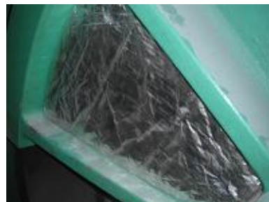
断熱板での開口閉鎖
