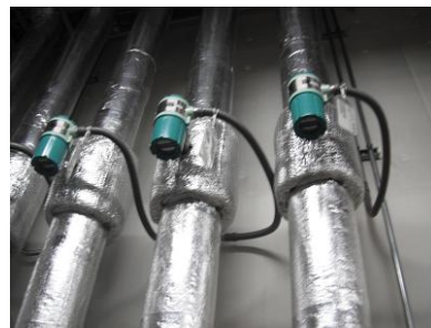
蒸気供給配管の流量計設置状況
