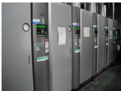
ボイラー設置状況
