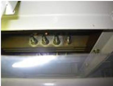
端子取り外し状況
