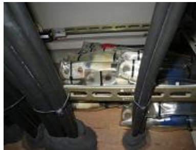
取り外し後のテーピング処理
