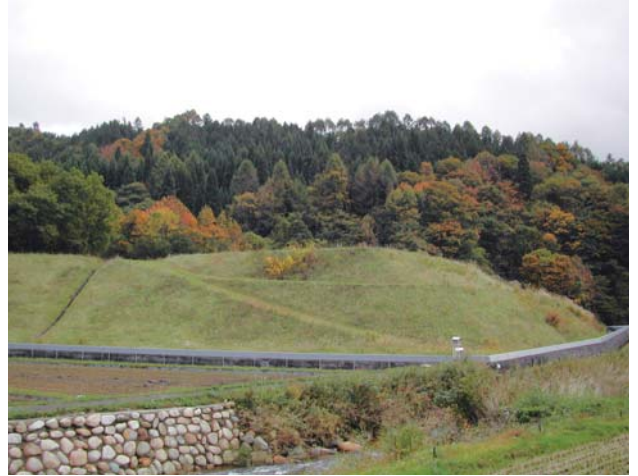
中津河大切坑捨石堆積場
