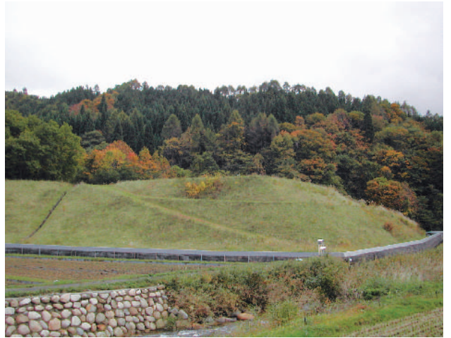
中津河大切坑捨石堆積場
