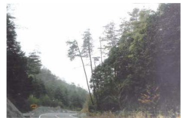
道路沿線の危険な被害木
