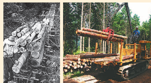
昔は丸太を人力で運ぶために木組みの道を作っていたが、今では作業道の整備や機械化が進んでいる
