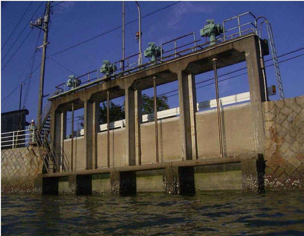
②開閉装置(開閉器)
