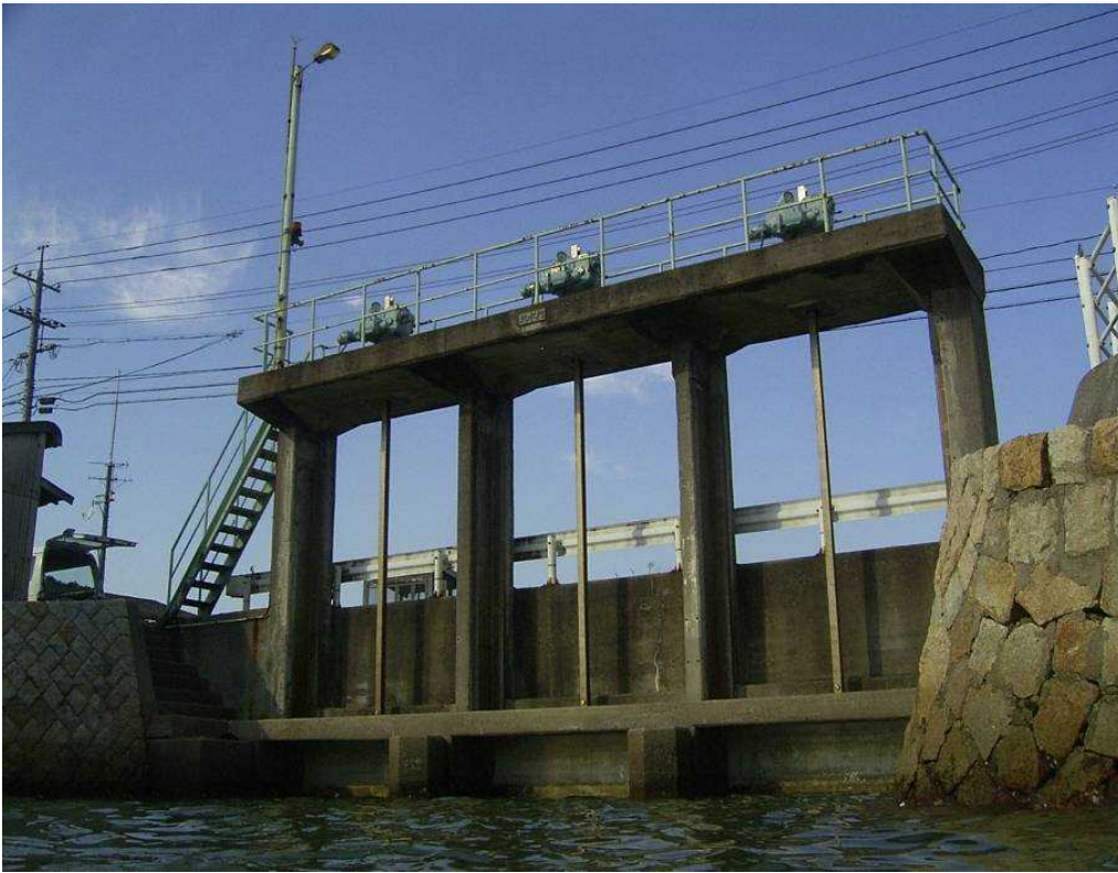
②開閉装置(開閉器)
