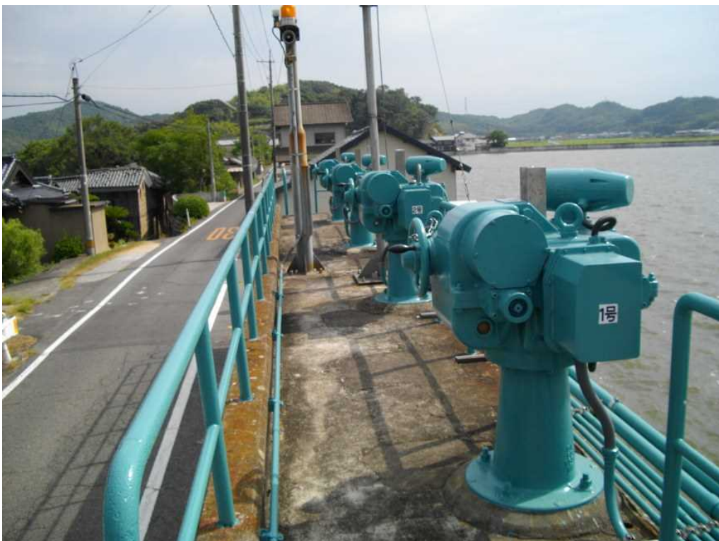
②開閉装置(開閉器)
