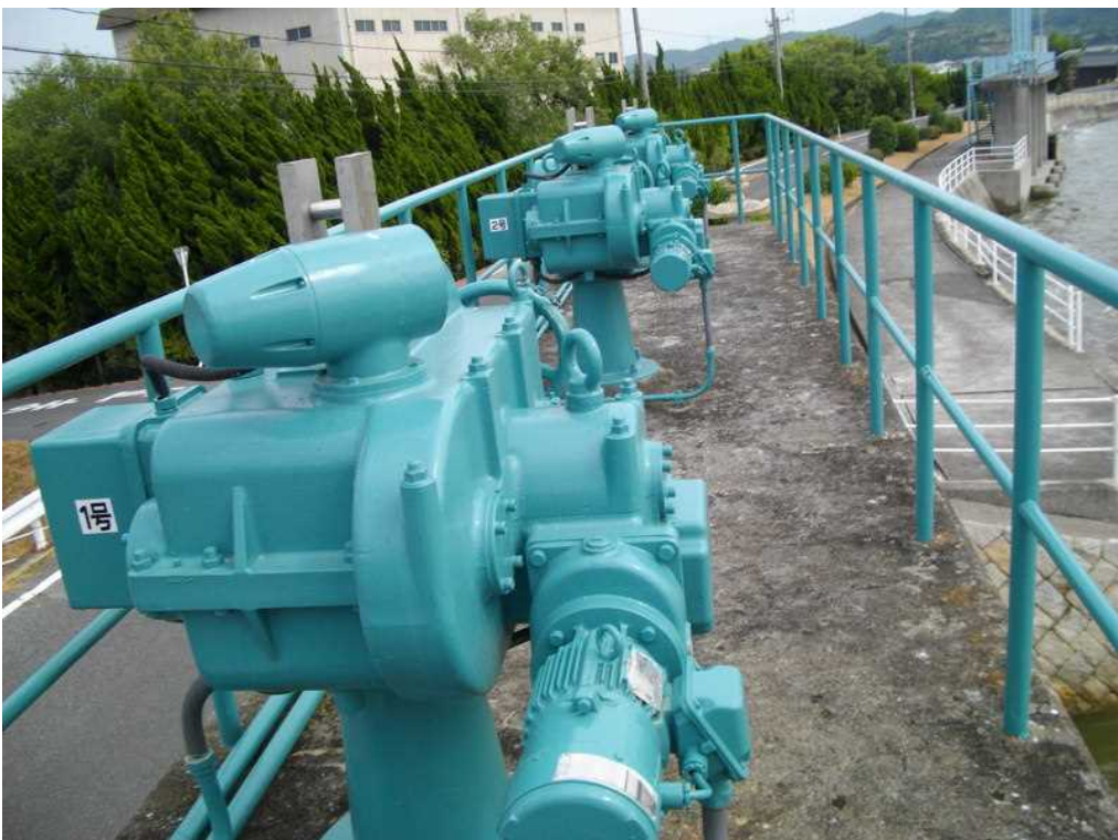
②開閉装置(開閉器)
