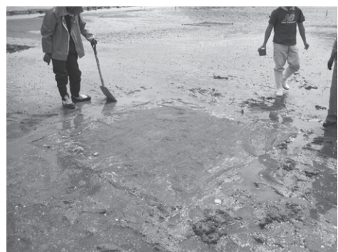
写真1 被覆網の設置状況
