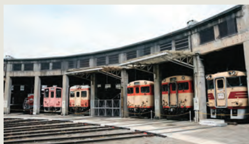
扇形機関車庫の全景
