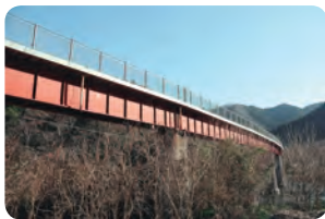
↑井倉～石蟹間 旧線にかかる旧第九高梁川橋梁。
