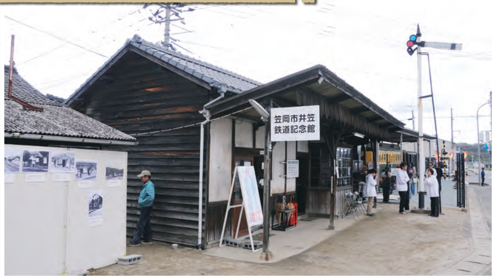
にいやま 新山駅舎を活用した井笠鉄道記念館。1号機関車と客車、貨車も保存されている。貨車では唯一の現存車両。
