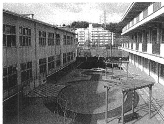
岡山工業高校(改修後)
