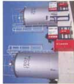
● BDF製品貯蔵タンク
