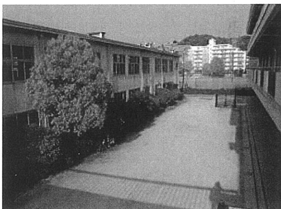
岡山工業高校(改修前)
