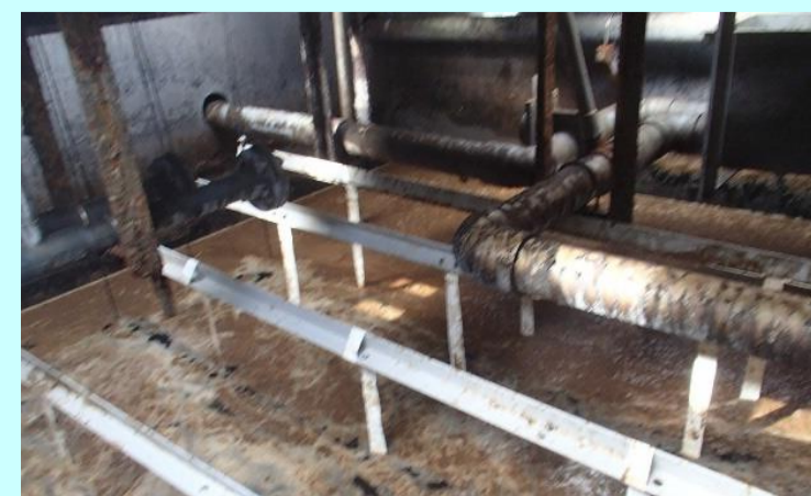
浄化処理槽内設置状況
