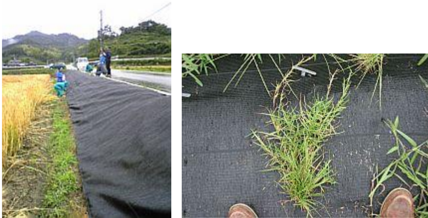
防草シート敷設
