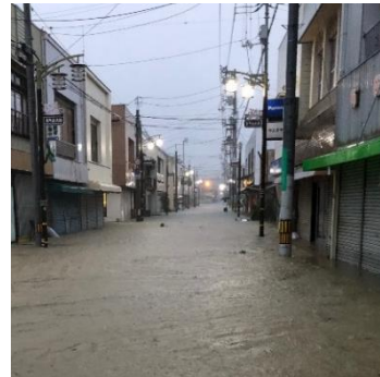
浸水により街路灯が故障
