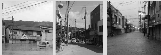
河川等の氾濫により商店街に浸水 浸水によりカー舗装が損傷 浸水により街路灯が故障
