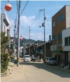
浸水によるカラー舗装損傷
