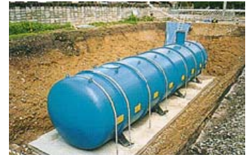
【耐震性貯水槽】
