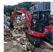
【重機によるガレキ撤去(広島県広島市)】
